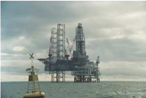
Einer der beiden Bohrtürme in der Bintuni-Bucht (Foto: S. Zöllner)
